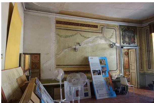
Figure 4: fissuration en voute de décharge
