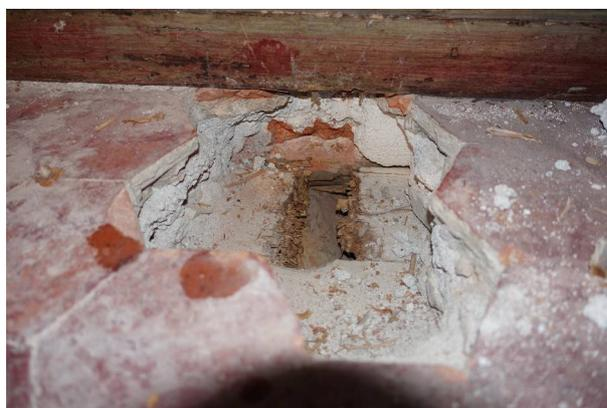
Figure 5: pas structure sous l'appui de la cloison
