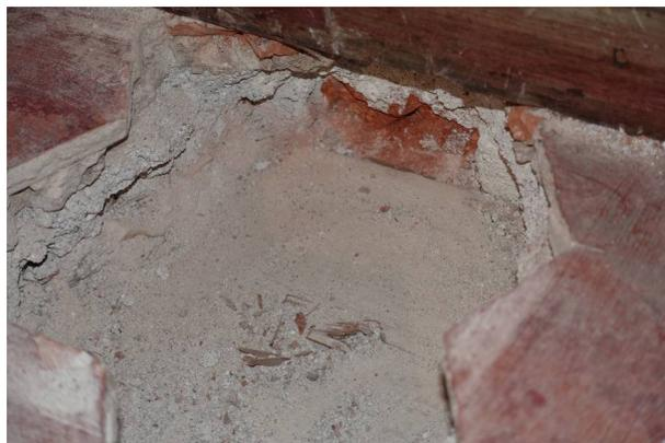
Figure 3: contact pied de cloison - plancher d'enfustage
