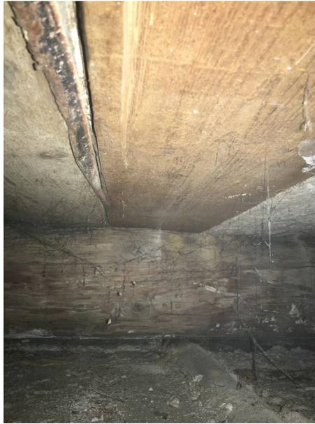
Figure 7: poutre diam 30~32 filante
